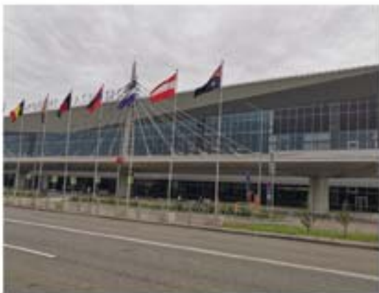
Аэропорт (г. Красноярск)
